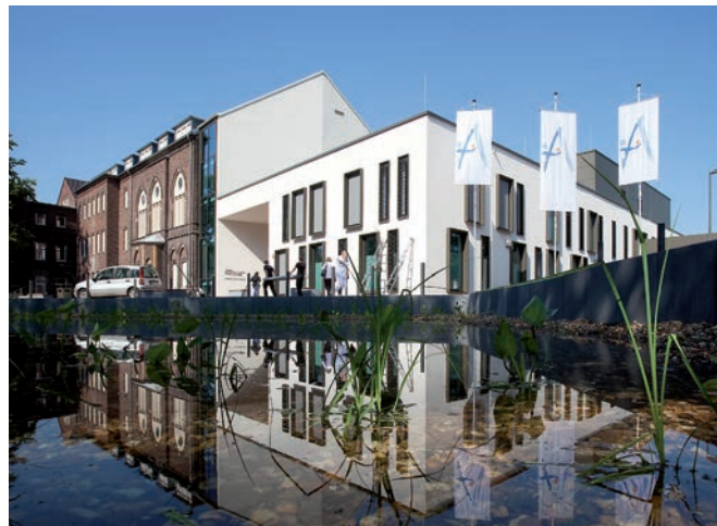
Das neue St. Alexius-/St. Josef-Krankenhaus
